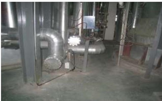
图 4 放射源前端剂量监控设备
