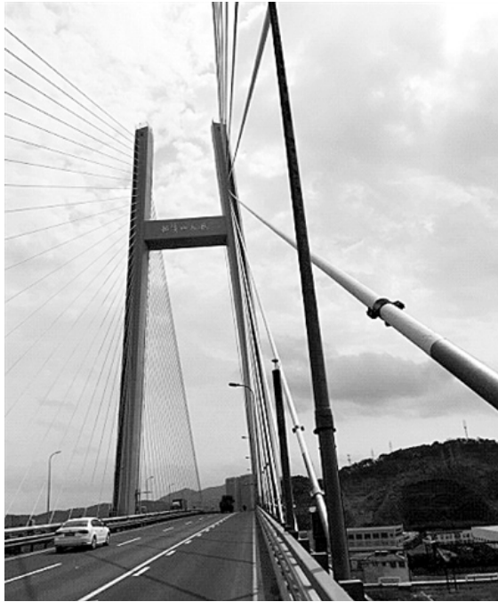
项目牵头单位部署的桥梁健康监测系统
